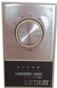
ベースボードヒーターダイヤル Dial type temperature control knob
